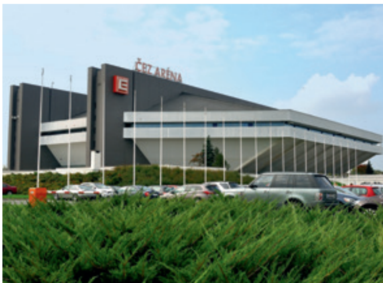
1986 wurde die Čez Aréna eröffnet – damals noch als „Kultur- und Sportpalast“. 2004 wurde das Gebäude anlässlich der Eishockey-WM der Männer gründlich renoviert und umbenannt. Im selben Jahr wurde der Worldcup Latein in dieser Halle ausgetragen. Foto: Estler
